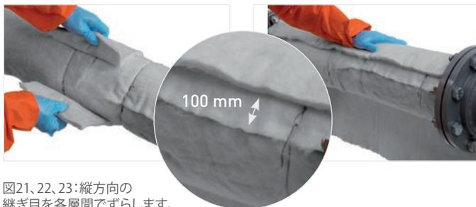
図21、22、23: 縦方向の継ぎ目を各層間でずらします。
