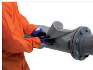
図25: 必要な積層数になるまで、連続してパイプに巻きつけます。縦方向の端が内側のレイヤーの始点にぴったり合うか、少し重なる箇所まで巻きつけを終了します。
