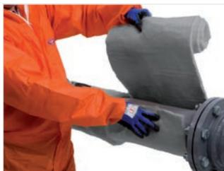
図24: 始点が配管の軸に沿っていることを確認します。必要に応じ、テープまたは接着剤を使用して軸位置に固定します。
